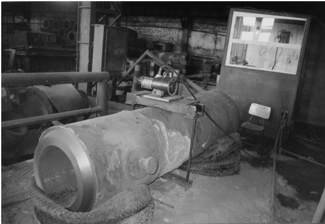
Рис 8.2. Закрепление виброблока на конструкции.
