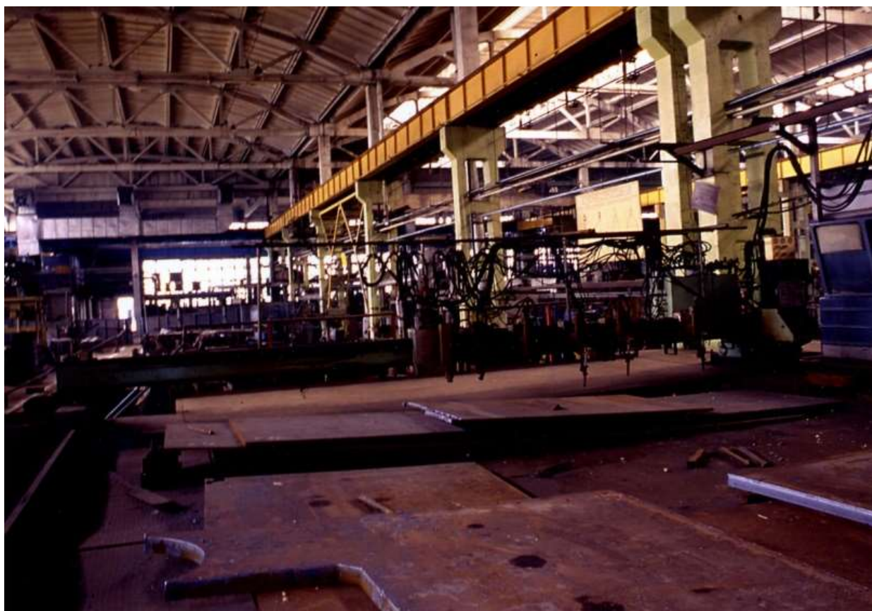
Рисунок 5.1 – Плазмо-різальна машина ремонтно-механічного заводу ПрАТ «АЗОТ»
