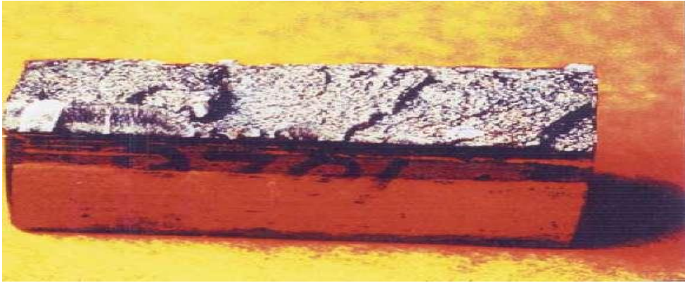
Рисунок А.33 – Крихкий злам (руйнування при швидкому поширенні тріщини без попередньої пластичної деформації)
